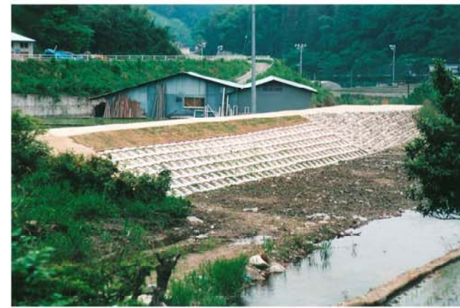
一次工事施工完了の状況
