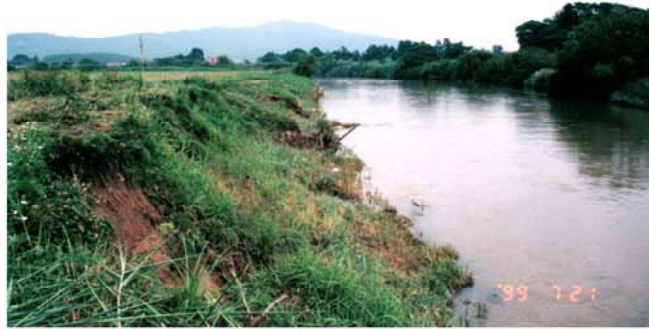
着工前の状況
