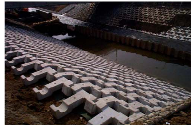
据付完了 左岸側より
