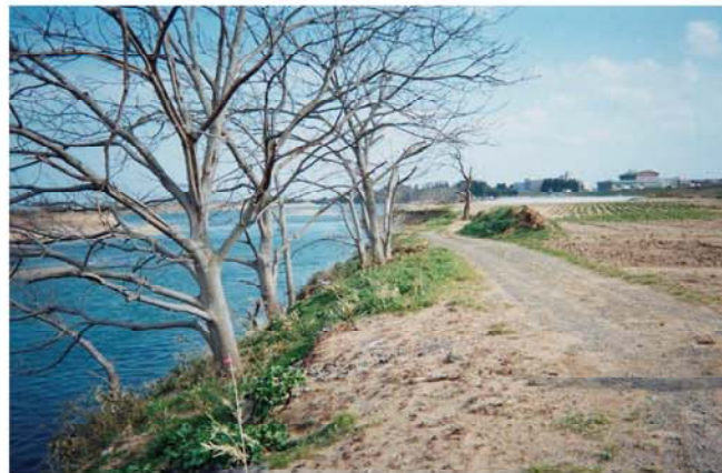
着工前の状況
