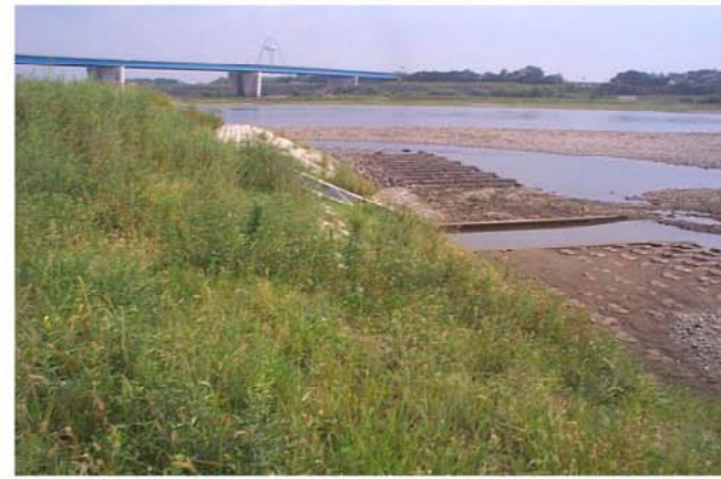
施工後5ヶ月半経過の状況
