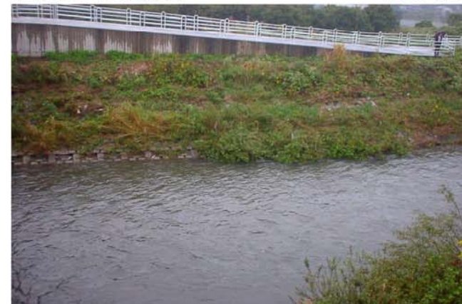
施工後2年7ヵ月 右岸側
