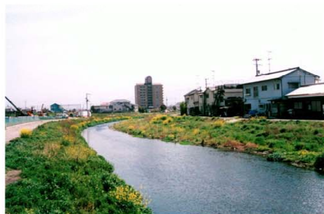
施工後2年8ヶ月
