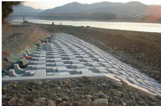
搬路までの施工状況
