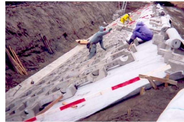
据付完了(上流側から)
