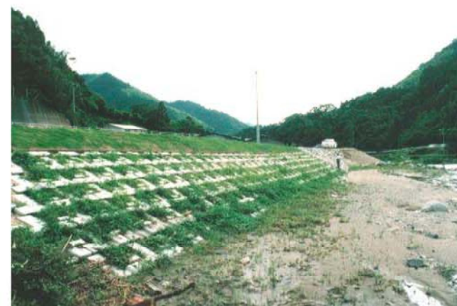
施工後1ヶ月半の状況
