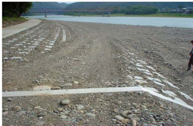
施工後1ヶ月経過の状況
