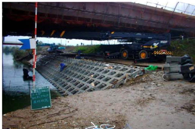
水中施工据付の様子(左岸側)
