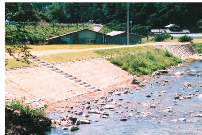
施工後3ヶ月の状況、上流は8月末第2期分施工完了
