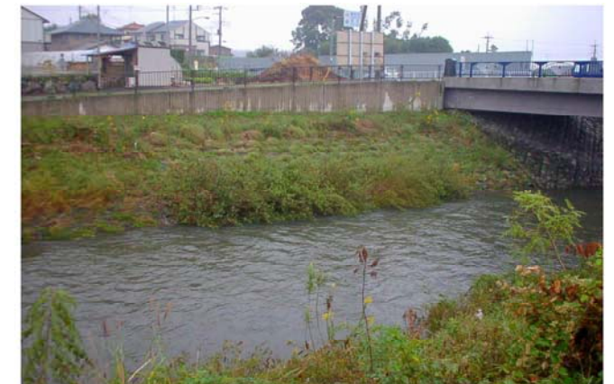
施工後2年7ヵ月 左岸側
